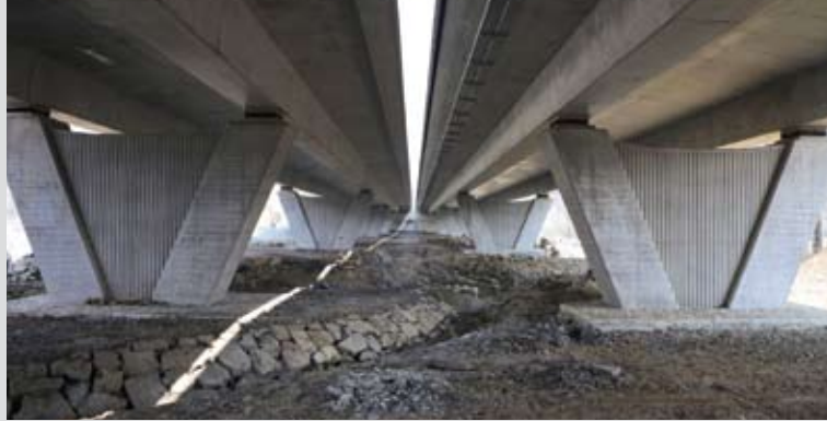
▲ Most v km 140,745 převádí dálnici ve výšce osmi metrů přes cennou údolní nivu s biokoridorem potoka Polančice a polní cestu v těsné blízkosti brněnského portálu tunelu Klimkovice. Nosnou konstrukcí mostu tvoří monolitický dvoutrámový nosník o pěti polích s rozpětími 24+3x36+24 m.
