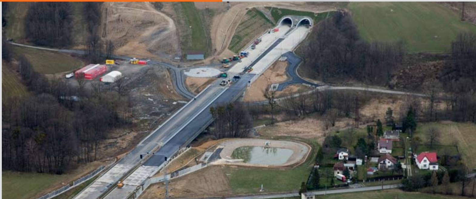
▲ Letecký pohled na brněnský portál tunelu Klimkovice s přistávací plochou pro vrtulníky, přemostění údolí potoka Polančice a polní cesty dálničním mostem
