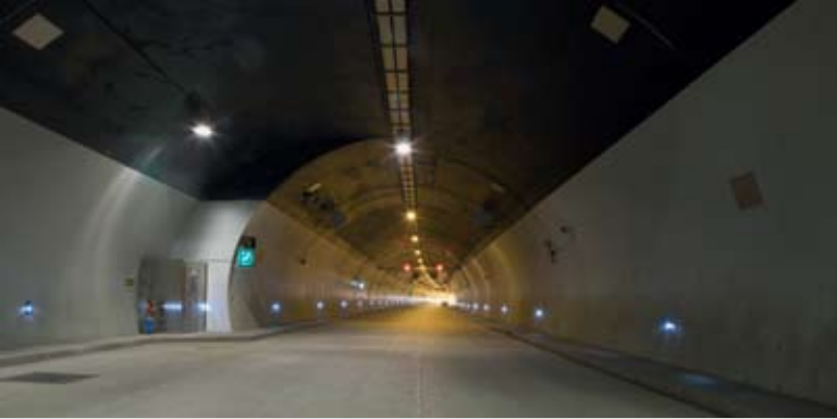
▲ Tunel Klimkovice, tunelová trouba B pro jízdní pás ve směru od Ostravy na Brno o celkové délce 1088 m. Pohled proti směru jízdy s bezpečnostním zářivem a hláskou tísňového volání systému SOS.
